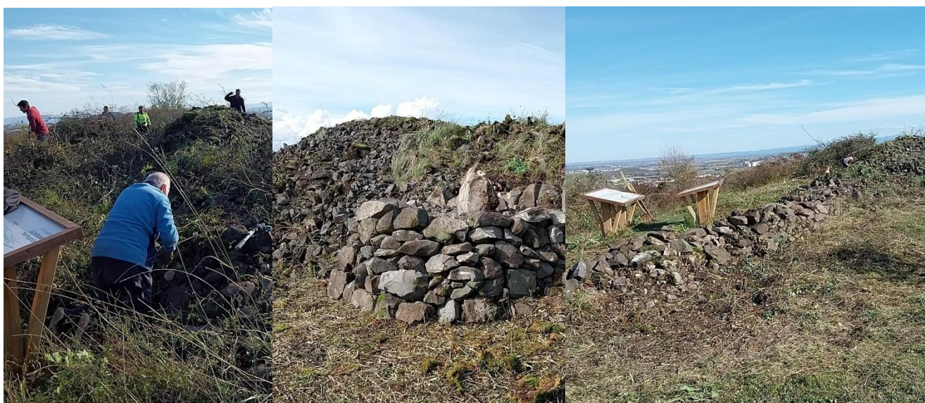
Figure 4 - Chantier de nettoyage d'une partie du muret côté table de lecture du paysage.
