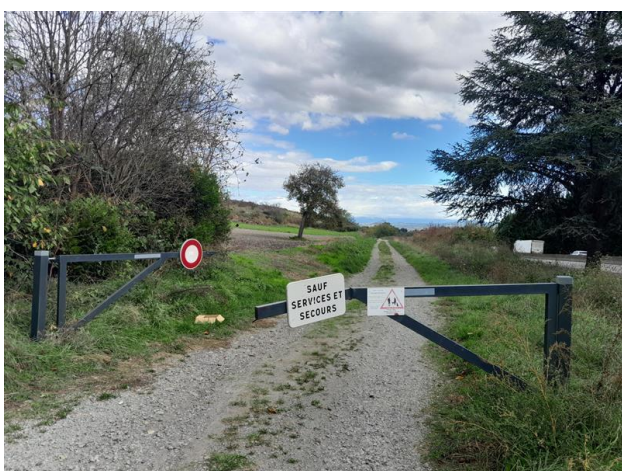
Figure 7 - Barrière d'accès dégradée. Octobre 2024
