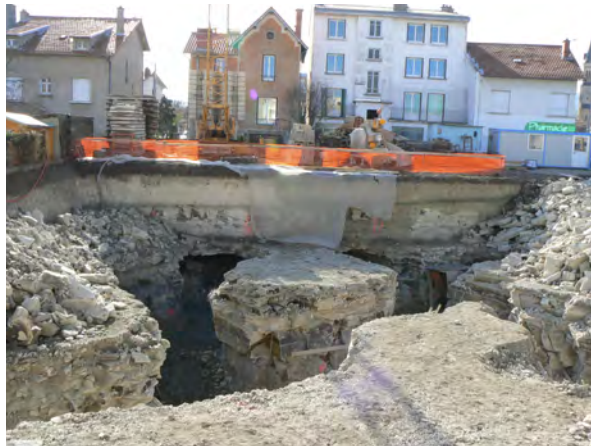
▲ Figure 30 : Effondrement de cavités souterraines sur la commune de Clermont-Ferrand (source: BRGM)
