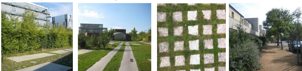
Exemples illustratifs : graviers, dallage de bois, pierres de treillis de pelouse, stabilisé ou terre armée, pavés drainant ou à joints engazonnés, bande de roulement.
