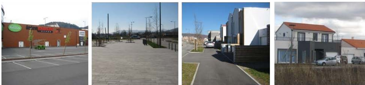
Exemples illustratifs : aire de parking en enrobé, allée piétonne en asphalte, en dallage ou en pavés jointoyés au ciment ou à la colle, terrasse en béton, toiture en tuile, zinc ou ardoise
