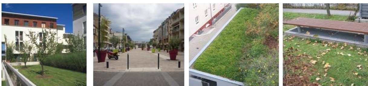
Exemples illustratifs : toiture terrasse végétalisée, dalle végétalisée au-dessus de dalle de parking, dispositif de végétalisation hors sol, en bacs ou pots.
